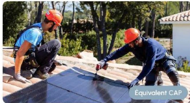
Installateur de panneaux photovoltaïques
