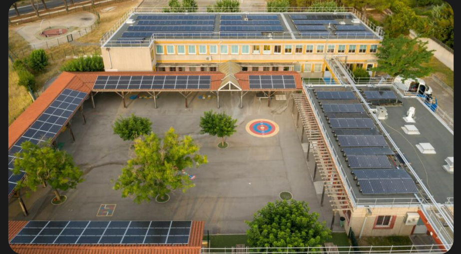
Installations photovoltaïques sur les toits du groupe scolaire de Cabriès-Calas, Bouches-du-Rhône (13)
